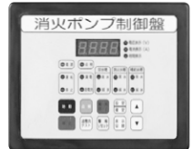
制御盤表示部
